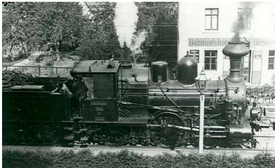
Rychlíková lokomotiva řady IIIb Saských královských drah vyráběná od roku 1873 dosahovala rychlosti až 70 km/h.
