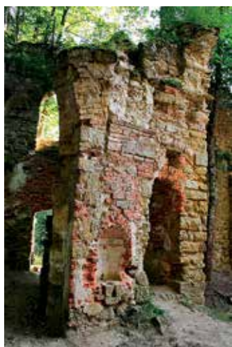
Zbytky barokního chrámu na Kopečku
