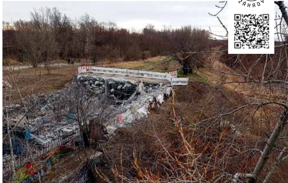
Demolice tunelu metra v roce 2019
