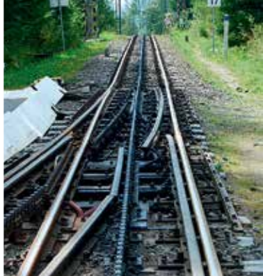
Ozubnicové výhybky i pohony jsou poměrně složité.
