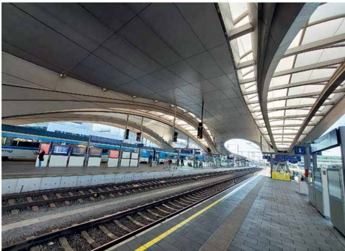
Kolejiště a nástupiště hlavního nádraží v Grazu kryje futuristická střecha.
